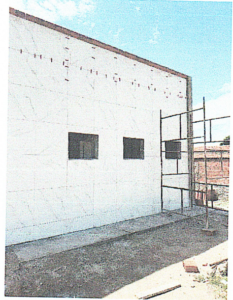
FOTO 18: Execução de revestimento cerâmico na fachada.
