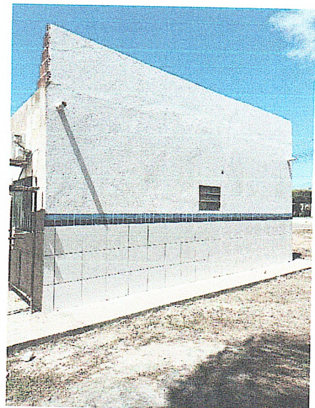
FOTO 19: Execução de revestimento cerâmico até meia parede com acabamento superior.
