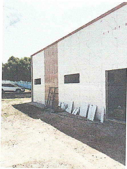
FOTO 17: Execução de revestimento cerâmico na fachada.
