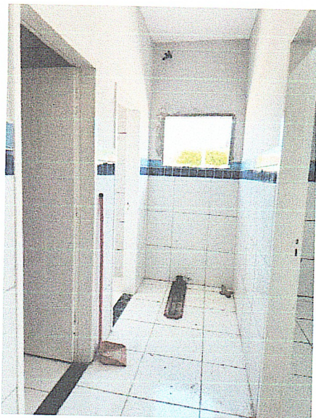
FOTO 7: Preparação de esquadrias e revestimento cerâmico.
