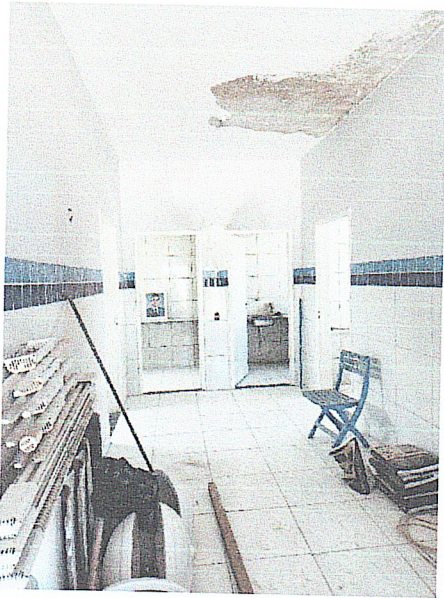
FOTO 1: Preparo de teto para receber pintura.
