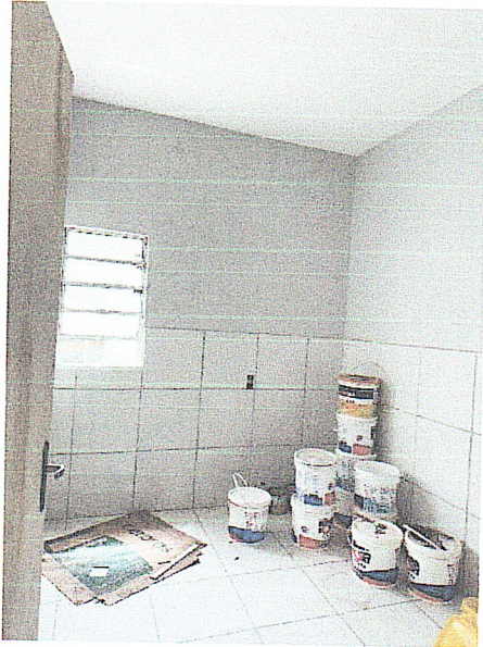
FOTO 9: PREPARO DE MATERIAL PARA PINTURA.
