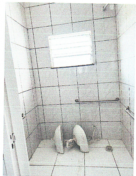
FOTO 16: Rejuntamento de piso cerâmico.
