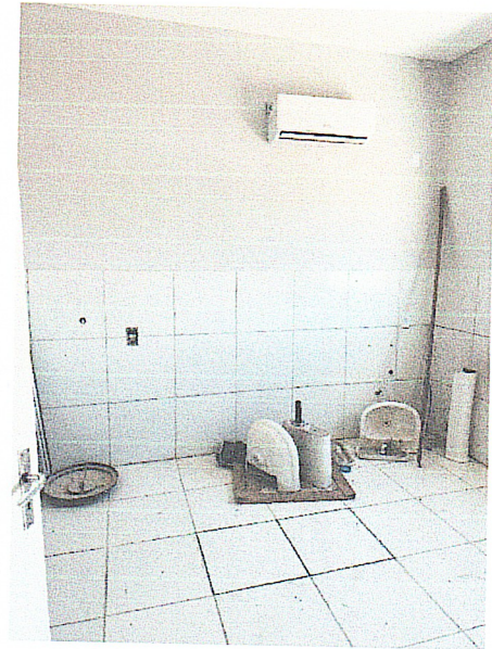
FOTO 6: Aplicação de cerâmica esmaltada e acabamento superior em pintura.
