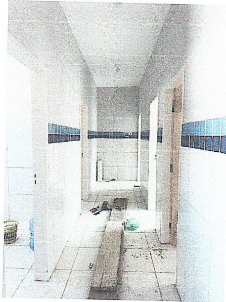
FOTO 2: Execução de acabamentos internos no corredor da edificação.
