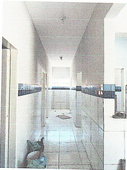
FOTO 3: Continuação do acabamento interno no corredor.
