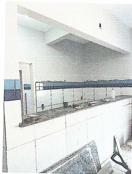
FOTO 4: Acabamento em pintura nas paredes internas.
