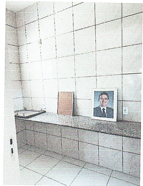
FOTO 14: Aplicação de cerâmica esmaltada.
