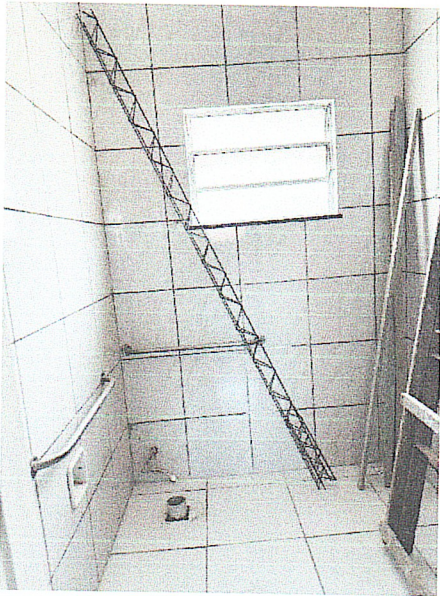
FOTO 13: Manutenção do sistema hidráulico.
