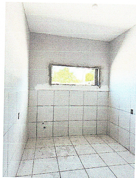
FOTO 8: Preparação de esquadrias e revestimento cerâmico, preparação de pontos elétricos.
