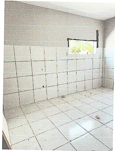
FOTO 10: Revestimento cerâmico e preparo de esquadrias.
