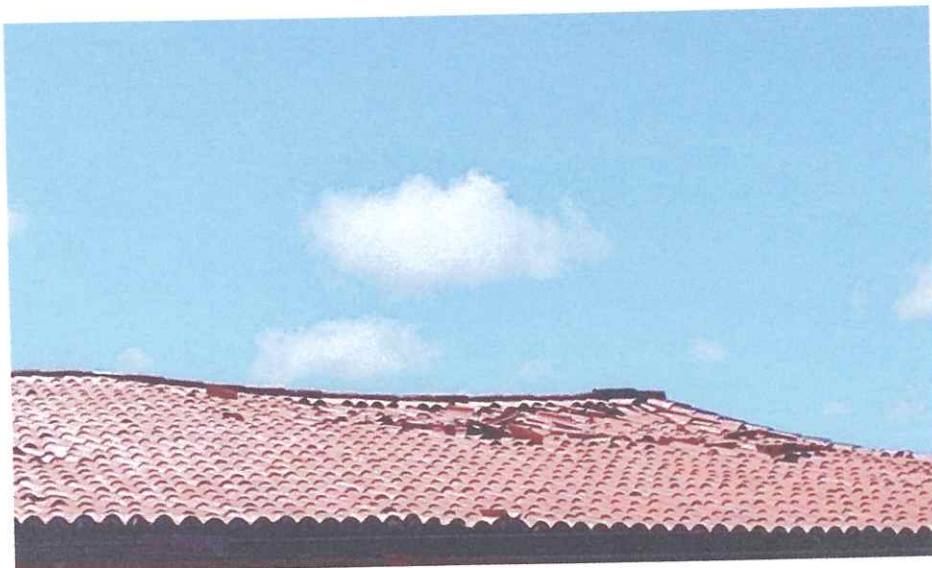
FOTO 07 – TELHADO DANIFICADO
