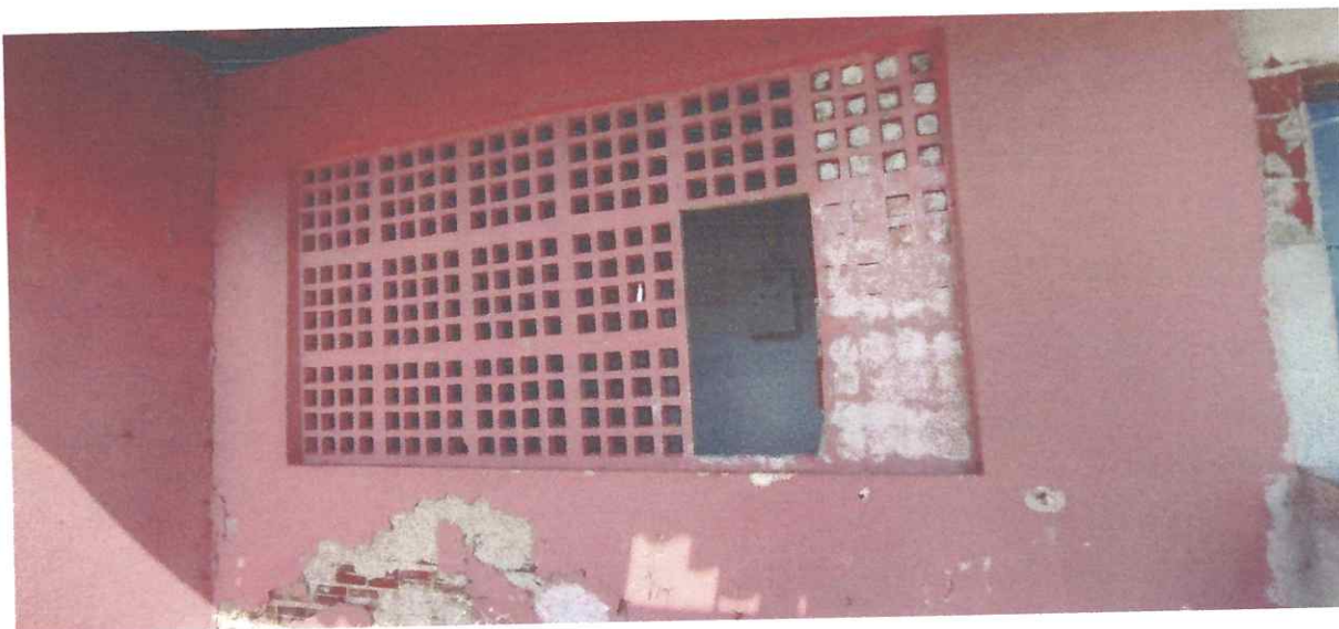
FOTO 05 – LOCAL DA INSTALAÇÃO DA PORTA
