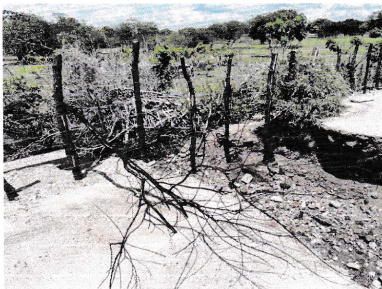
Figura 16 – Estrada da Barra II (P1)
