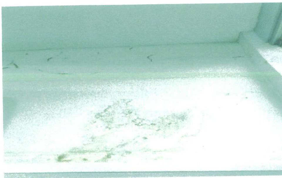
FOTO 18 – PINTURA DANIFICADA
