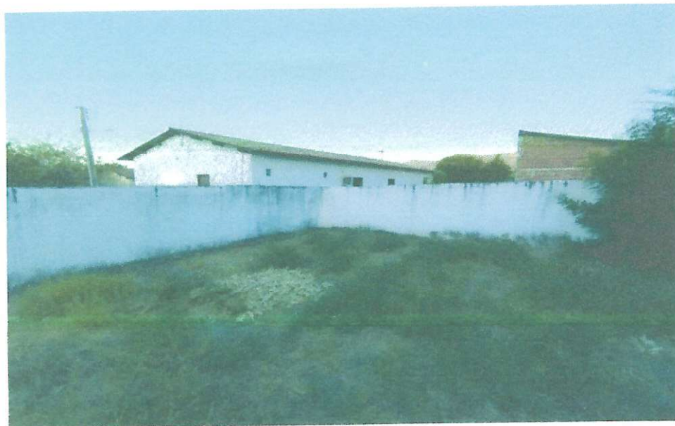
FOTO 31 – PISO DO ESTACIONAMENTO DANIFICADA
