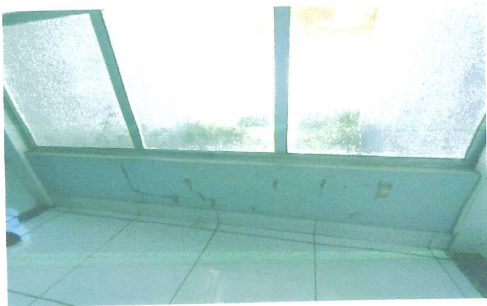
FOTO 22 – REBOCO DANIFICADO
