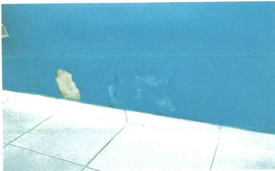
FOTO 25 – REBOCO DANIFICADO
