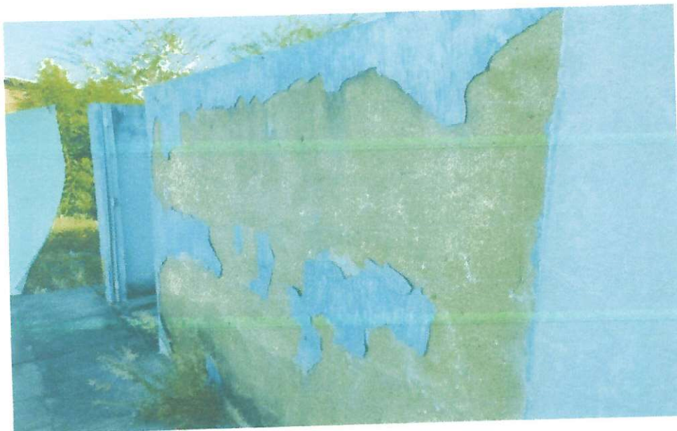
FOTO 13 – PAREDE QUE SERÁ DEMOLIDA
