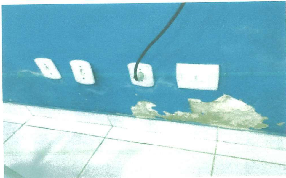
FOTO 24 – REBOCO DANIFICADO
