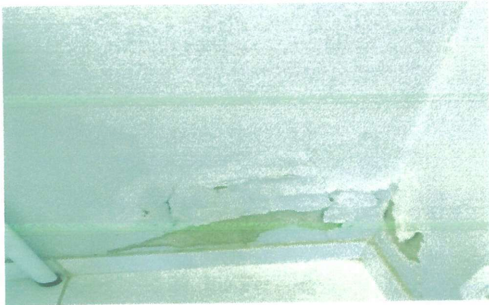
FOTO 23 – REBOCO DANIFICADO
