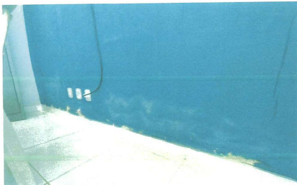
FOTO 26 – REBOCO DANIFICADO
