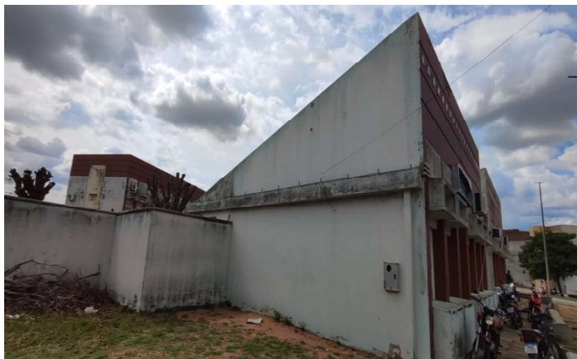
FOTO 17 – LOCAL DA INSTALAÇÃO DE JANELAS DA SALA 07
