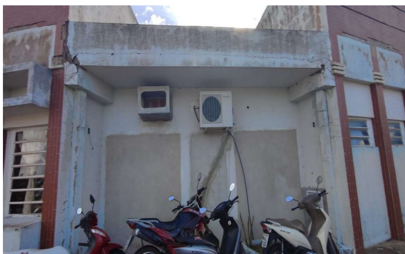
FOTO 16 – LOCAL DA INSTALAÇÃO DE JANELAS DA SALA 01
