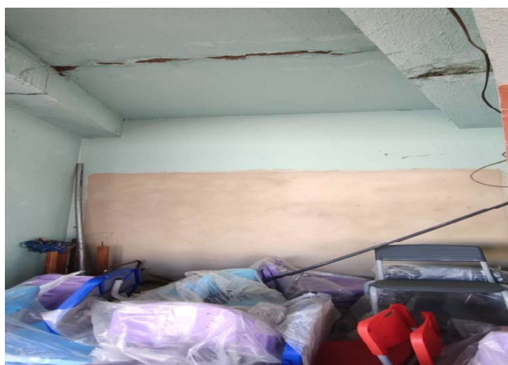
FOTO 18 – LOCAL DA INSTALAÇÃO DA PORTA 01
