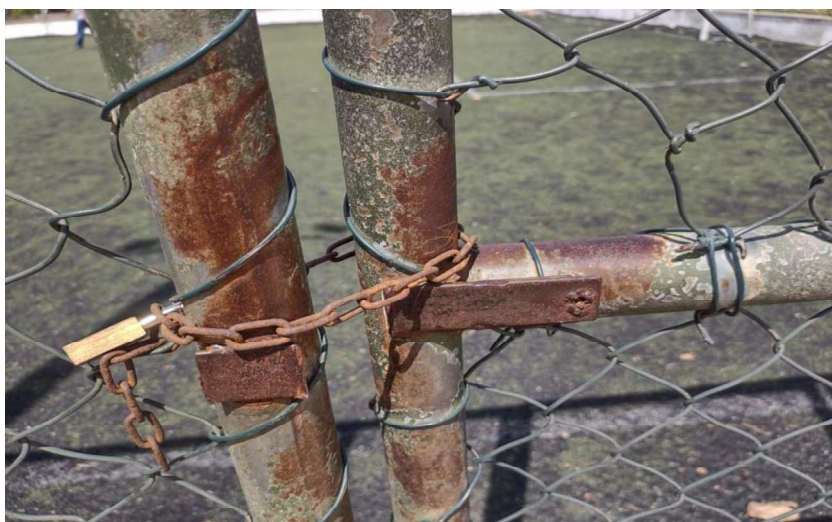
FOTO 02 – ALAMBRADOS DANIFICADOS E ENFERRUJADOS COM CORROSÃO.
