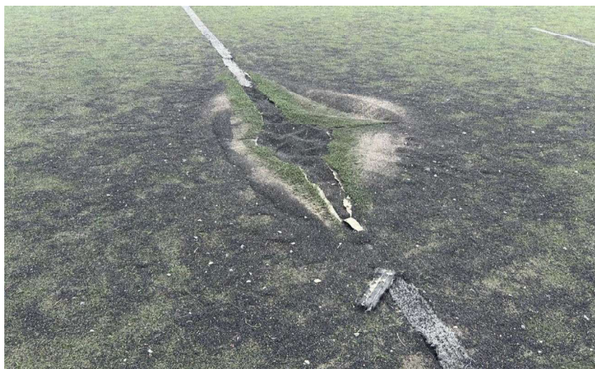
FOTO 09 – BURACOS NO GRAMADO DA ARENINHA DEVIDO AO USO.
