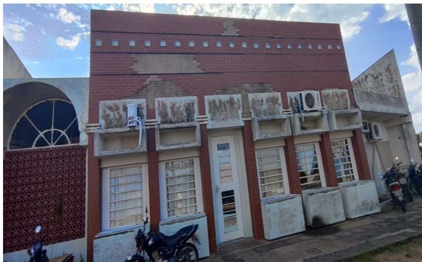
FOTO 03 – PINTURA DANIFICADA
