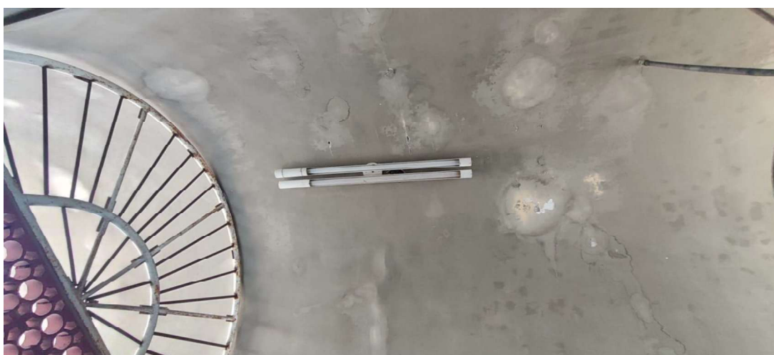
FOTO 06 – PINTURA DANIFICADA
