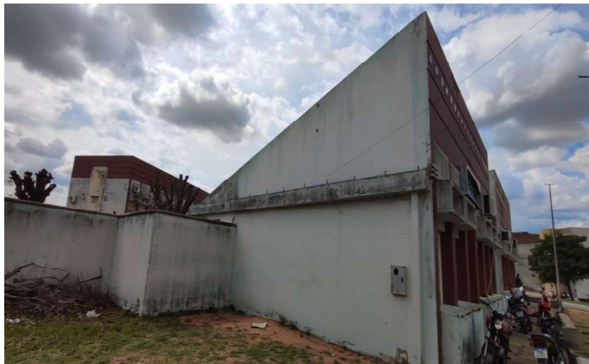
FOTO 17 – LOCAL DA INSTALAÇÃO DE JANELAS DA SALA 07
