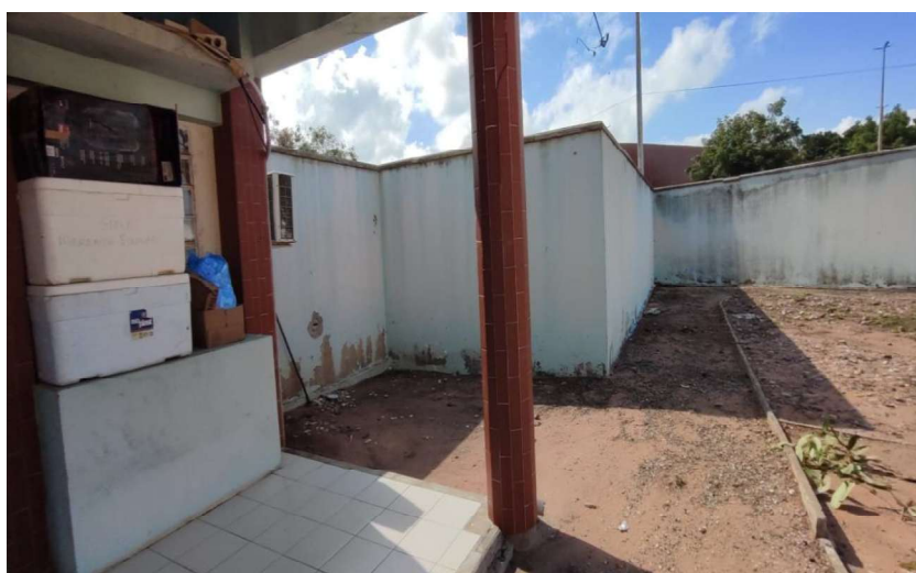
FOTO 08 – LOCAL DA CONSTRUÇÃO DA SALA 08
