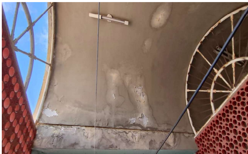
FOTO 05 – PINTURA DANIFICADA
