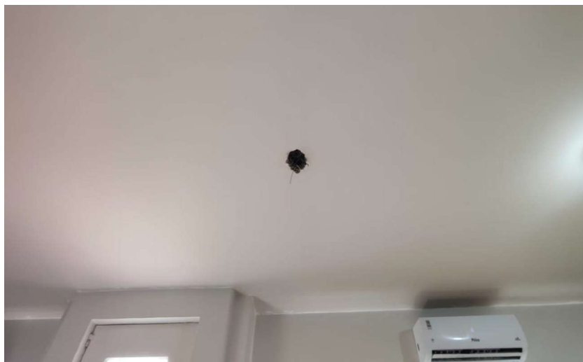
FOTO 15 – LUMINARIAS DANIFICADAS
