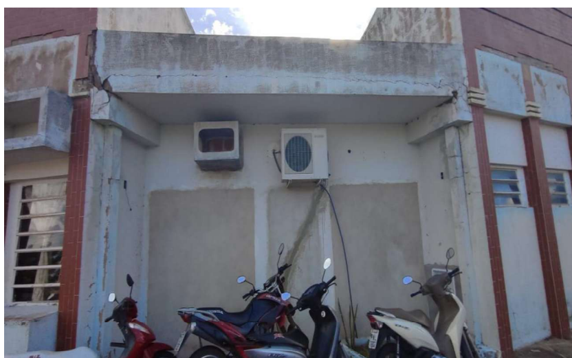
FOTO 16 – LOCAL DA INSTALAÇÃO DE JANELAS DA SALA 01
