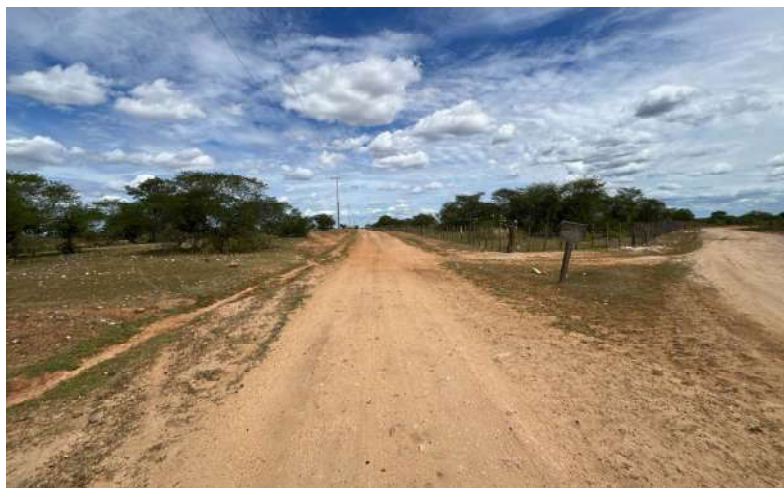
FOTO 01 – INÍCIO DA ESTRADA VICINAL BARRA II
