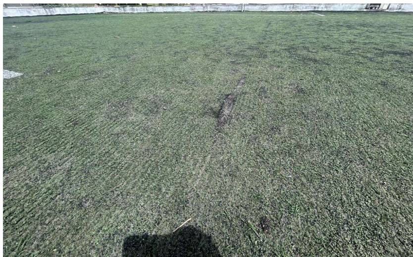
FOTO 08 – GRAMADO ARENINHA DESGASTADO DEVIDO AO USO.
