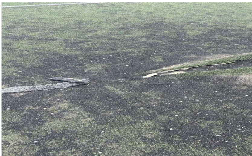
FOTO 11 – BURACOS NO GRAMADO DA ARENINHA DEVIDO AO USO.
