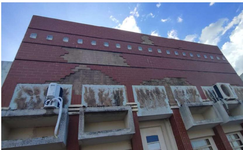
FOTO 02 – REVESTIMENTO CERAMICO DANIFICADO
