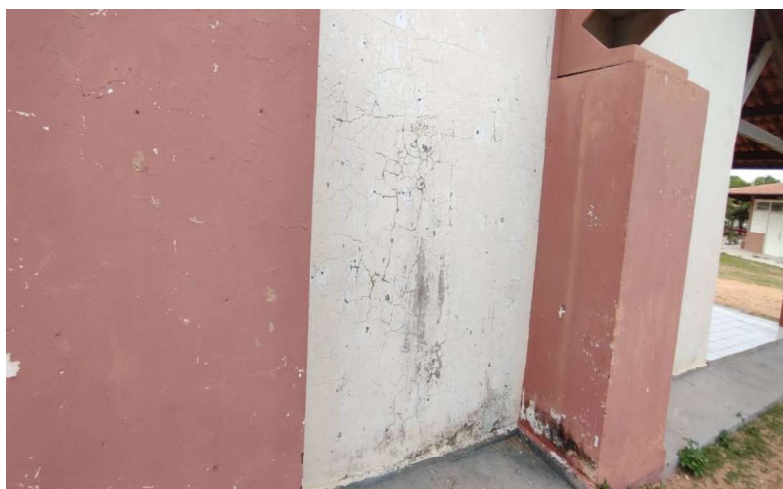
FOTO 08 – REBOCO DANIFICADO
