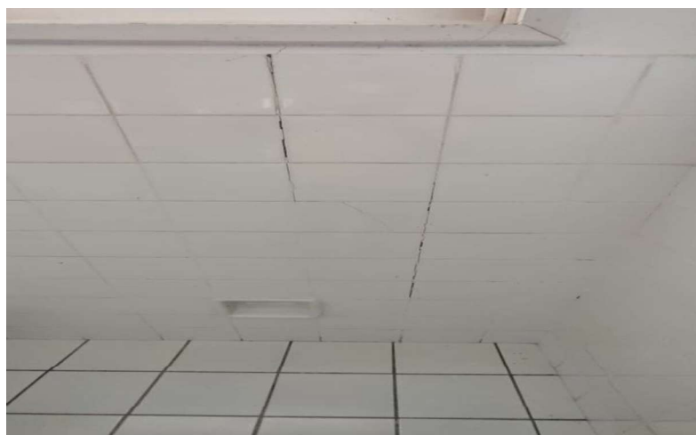
FOTO 14 – REVESTIMENTO DANIFICADO
