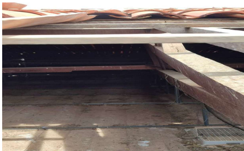
FOTO 02 – TESOURA DANIFICADA
