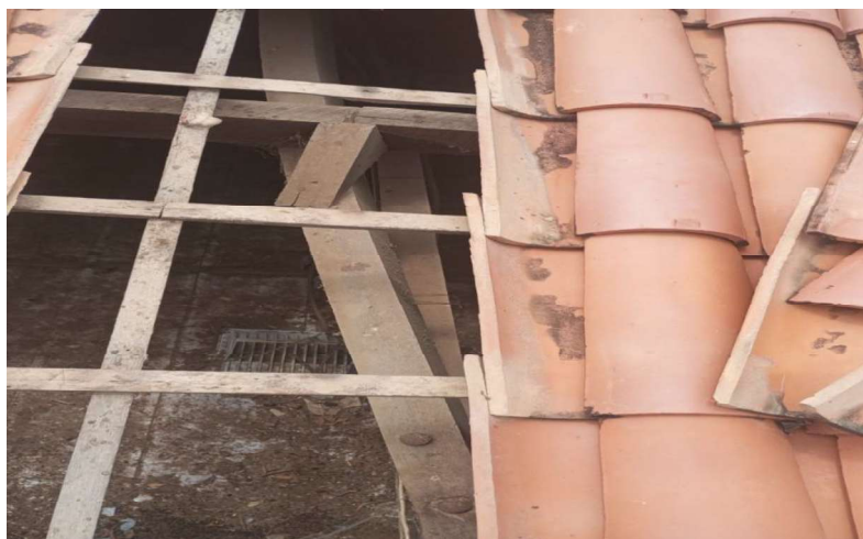
FOTO 01 – TESOURA DANIFICADA
