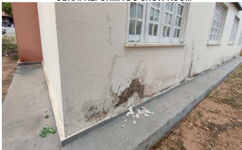
FOTO 07 – REBOCO DANIFICADO
