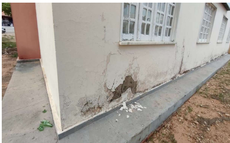
FOTO 09 – REBOCO DANIFICADO
