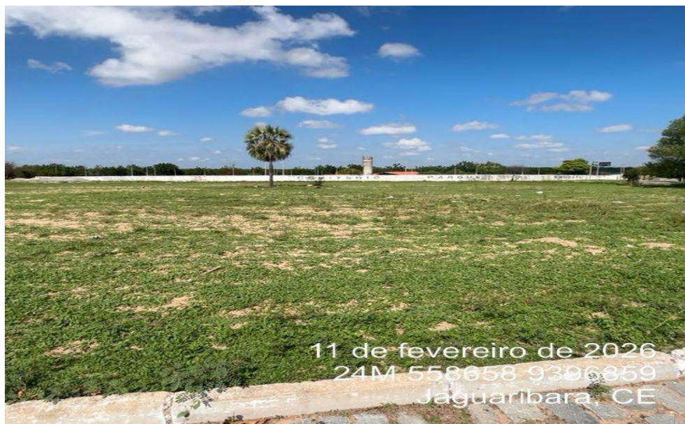
FOTO 02 – LOCAL DA AMPLIAÇÃO
